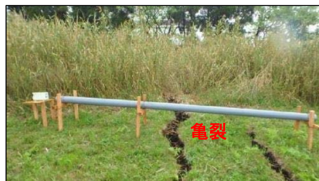
①阿蘇大橋崩壊斜面 上部亀裂状況
