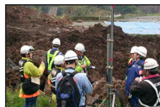
緊急消防援助隊との打合せ状況
