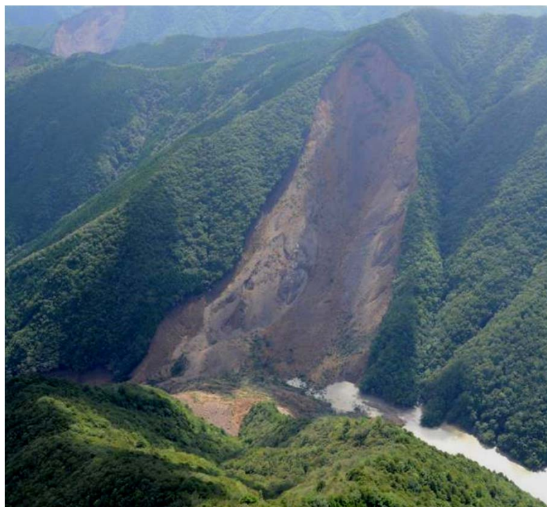
紀伊半島台風12号災害・赤谷地区 ＜改正土砂法に基づく緊急調査を実施＞
