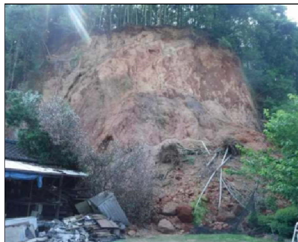
自然斜面崩壊状況（熊本県益城町）
