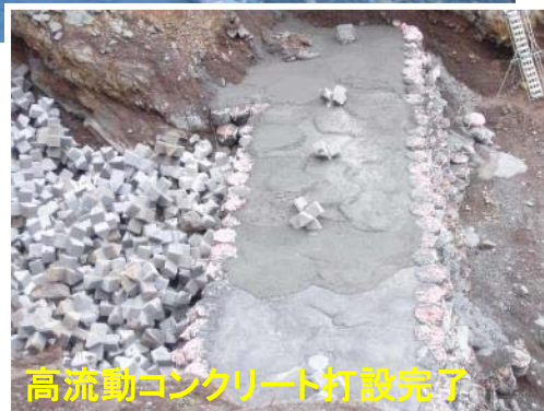
コンクリートブロック据付状況
