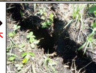
③外輪山カルデラ壁上部 亀裂の状況（山田川）
