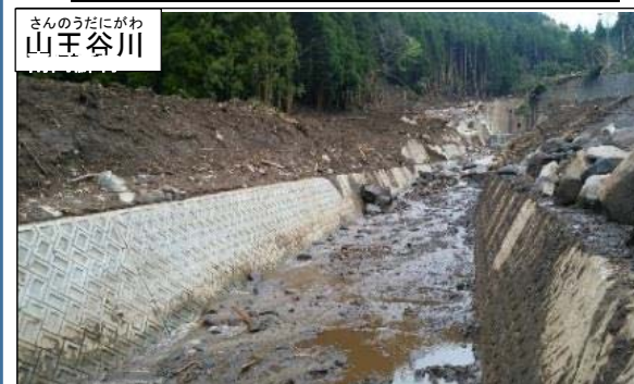
流路閉塞土砂掘削状況(4月25日完了)
