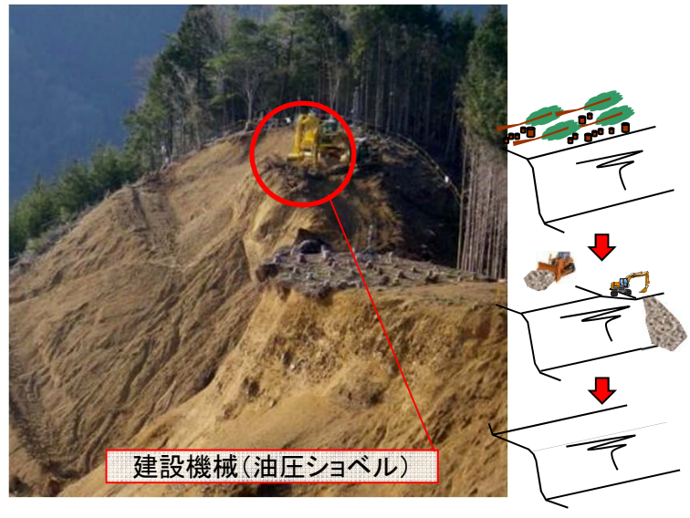
崩壊斜面上部の排土 5,000m 3
