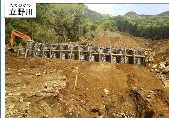
大型土のう設置状況(4月22日完了)
