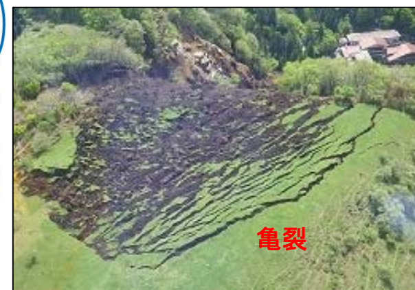
④阿蘇山カルデラ内部の崩壊箇所 上部亀裂状況（垂玉川1）
