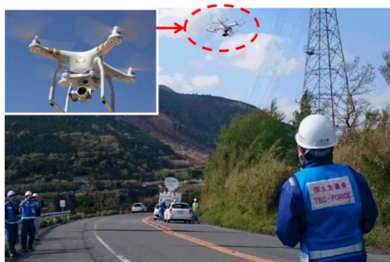
ドローン操作状況 (阿蘇大橋地区付近)
