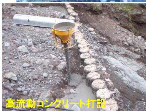
高流動コンクリート打設
