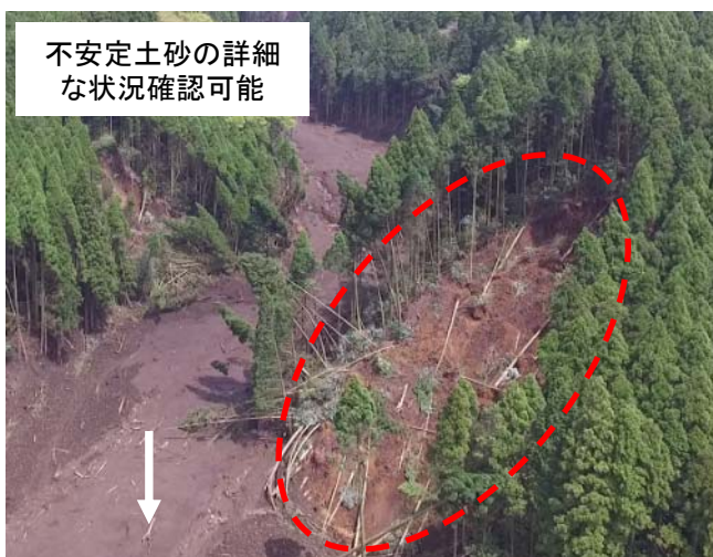
山腹崩壊の状況 (撮影4/19 山王谷川地区)
